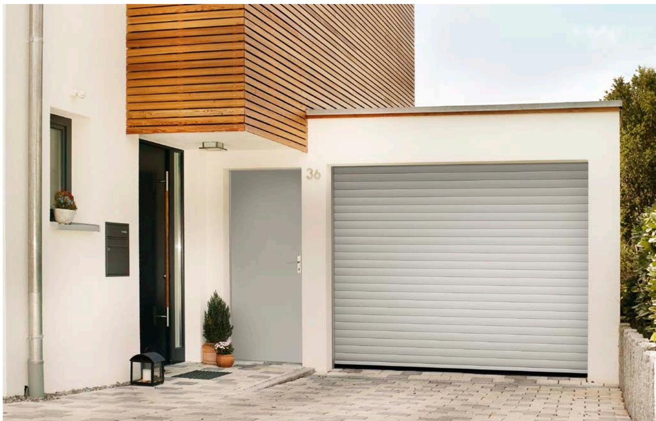
Rolltore haben gegenüber dem Sektionaltor den Vorteil, dass keine Deckenfläche über dem Innenraum der Garage benötigt wird.
